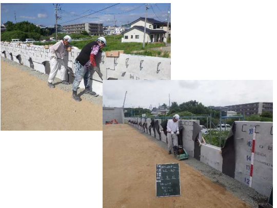
コンクリート壁面材(3段目)設置状況
