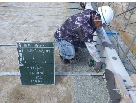
ストリップ設置(ボルト締付け)状況
