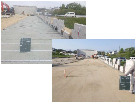
ストリップ設置～路体盛土転圧完了状況
