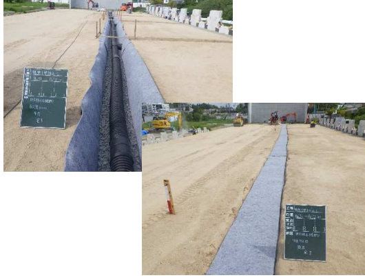
排水工(暗渠φ200、吸出防止剤)設置状況
