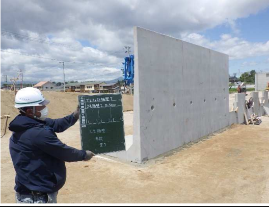
L型擁壁設置状況
