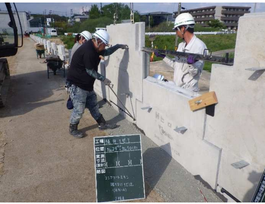
コンクリート壁面材(2段階)設置状況
