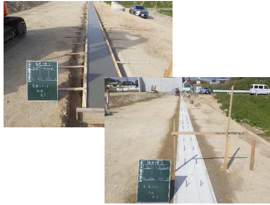
補強土壁基礎(コンクリート打設～差筋)状況
