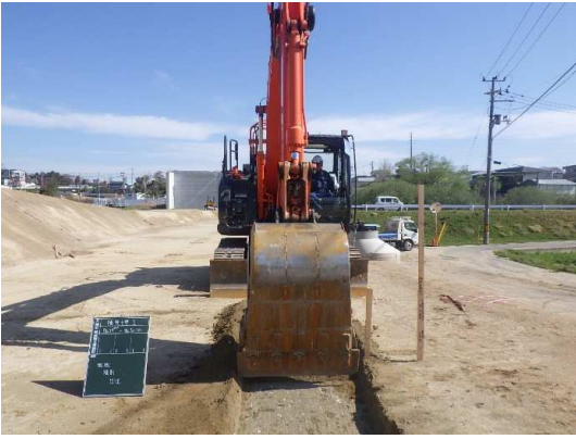
補強土壁基礎(掘削)状況
