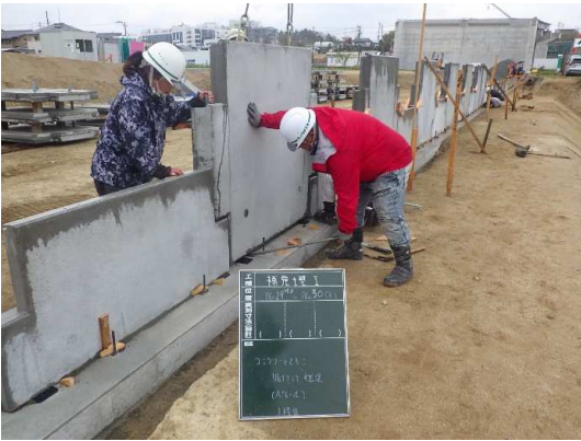
コンクリート壁面材(1段目)設置状況
