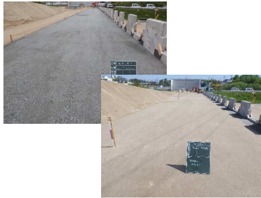
路体盛土転圧状況
