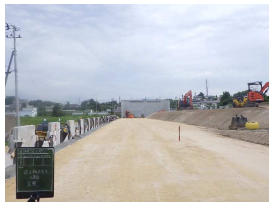
路体盛土転圧(6層目)状況
