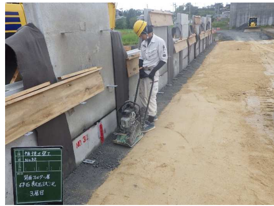
コンクリート壁面材(背面フィルター層)設置状況
