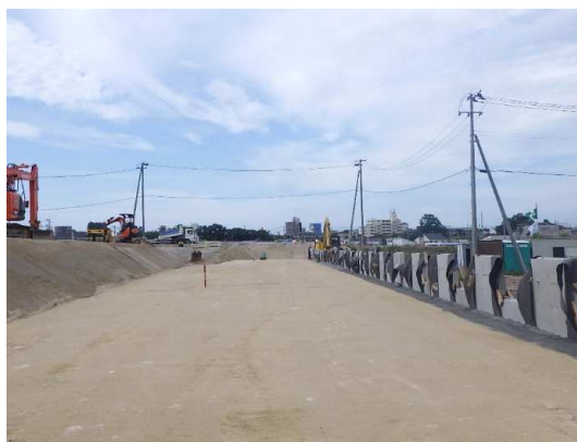
路体盛土転圧(6層目)状況
