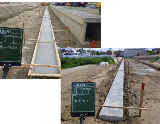
補強土壁基礎(コンクリート打設)状況
