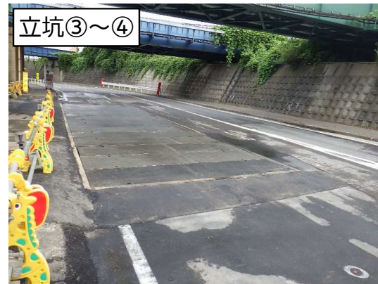
立坑③～④ 覆工板設置完了
