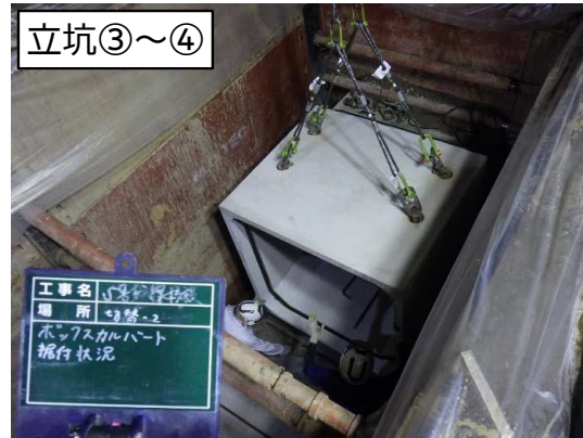
立坑③～④ ボックスカルバート布設状況
