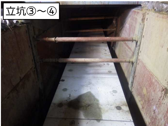
立坑③～④ ボックスカルバート布設完了
