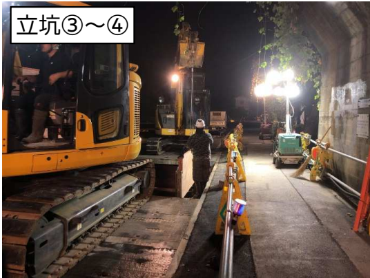
立坑③～④ 土留め設置状況
