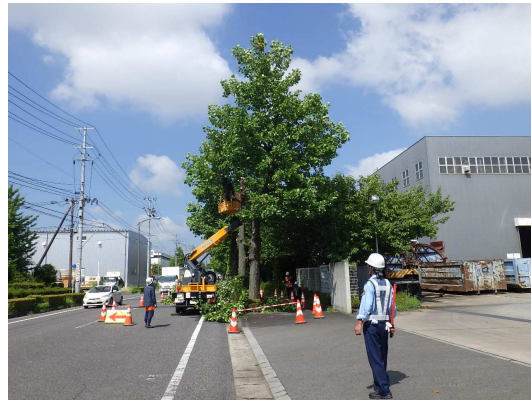
植栽撤去状況
