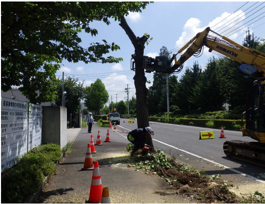
植栽撤去状況
