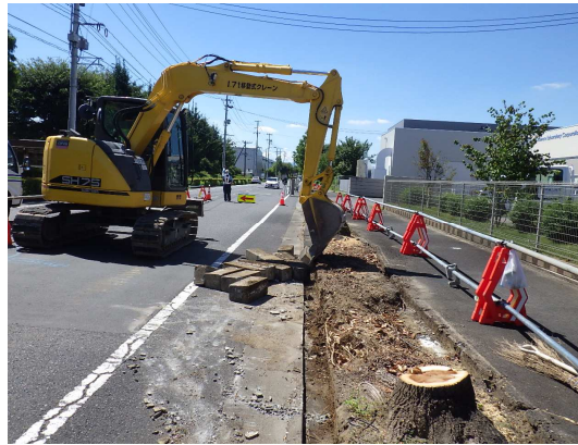
歩車道境界ブロック等撤去状況
