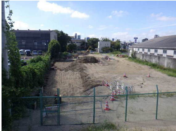
既設放流渠撤去部埋戻し状況
