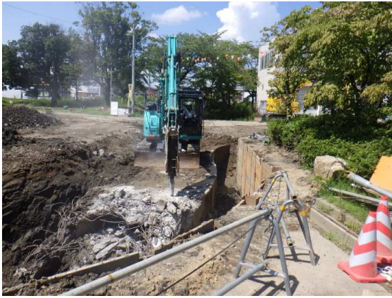
既設放流渠撤去状況
