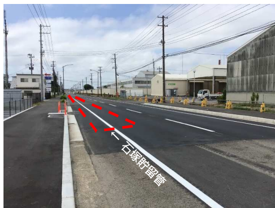
発進立坑部舗装本復旧完了
