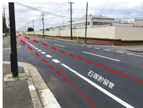
分水・取付人孔部舗装本復旧完了
