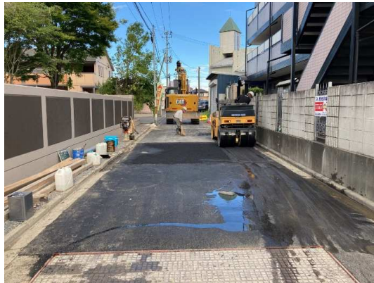
舗装仮復旧状況
