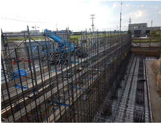
L型擁壁鉄筋完了
