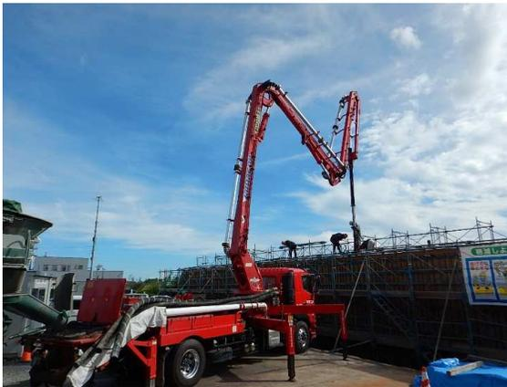
L型擁壁コンクリート打設状況
