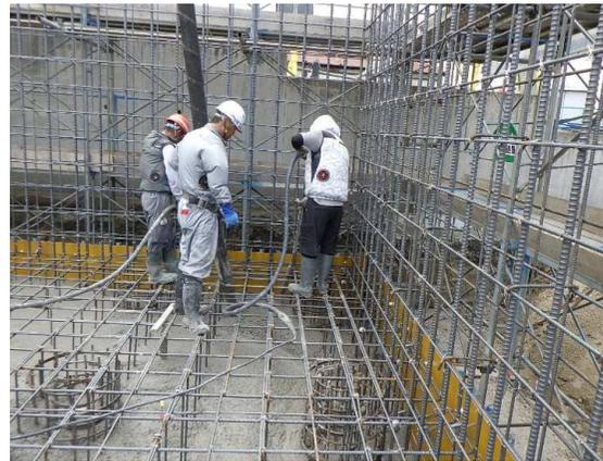
L型擁壁コンクリート打設状況
