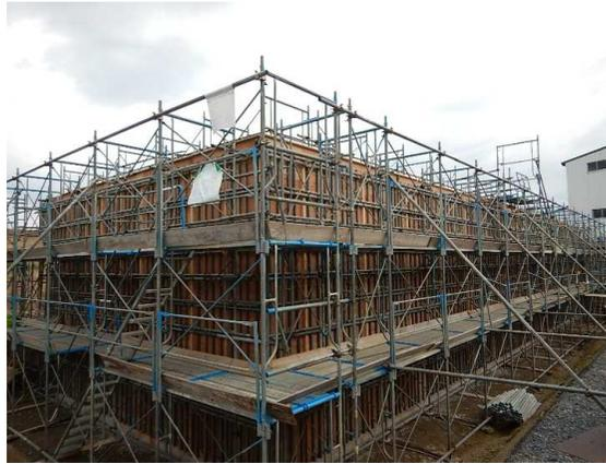
L型擁壁型枠完了
