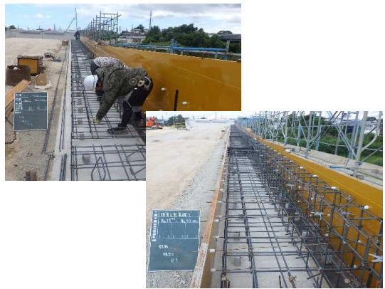
独立L型基礎(配筋)設置状況
