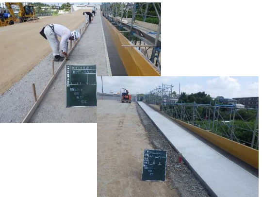
独立L型基礎(砕石～基礎コンクリート)設置状況
