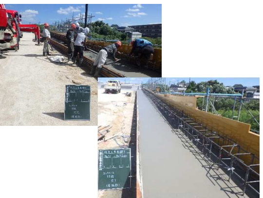
独立L型基礎(コンクリート打設)設置状況
