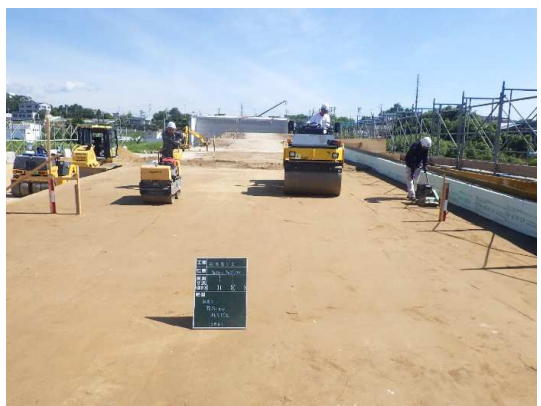
路床盛土(敷き均し～転圧)状況
