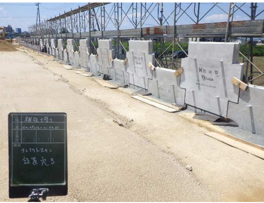
コンクリート壁面材設置状況
