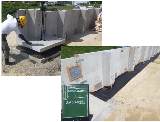
L型擁壁設置状況
