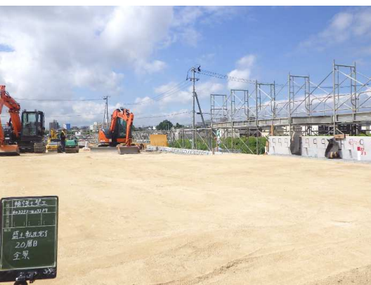
路体盛土転圧(20層目)状況
