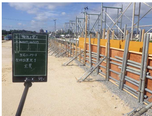
笠石コンクリート(型枠)設置状況
