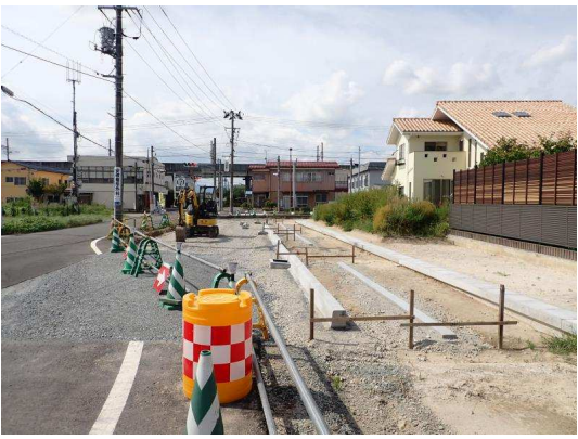
排水工、歩車道境界ブロック設置状況
