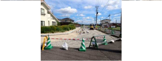
掘削(床掘)、排水工、下層路盤工 施工状況
