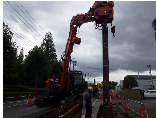
親杭設置状況
