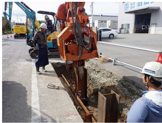
親杭設置状況
