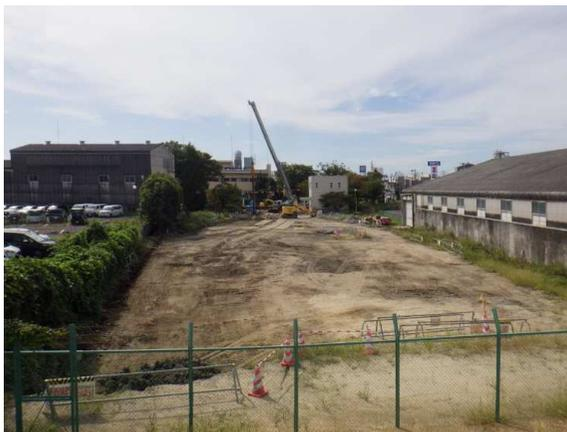
既設放流渠撤去部埋戻し状況
