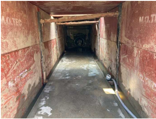
土留め・基礎版設置完了
