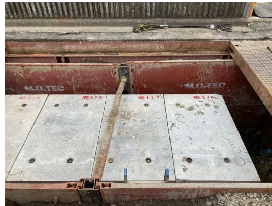
ボックスカルバート布設完了
