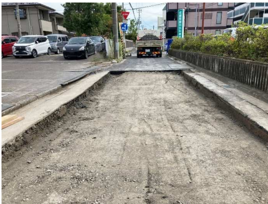
ボックスカルバート埋戻し状況
