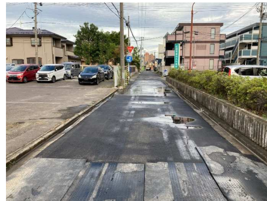
舗装仮復旧状況
