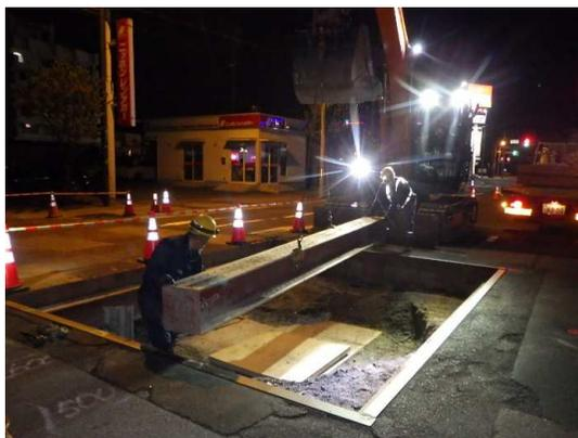
分水人孔③取込人孔覆工板受桁撤去状況
