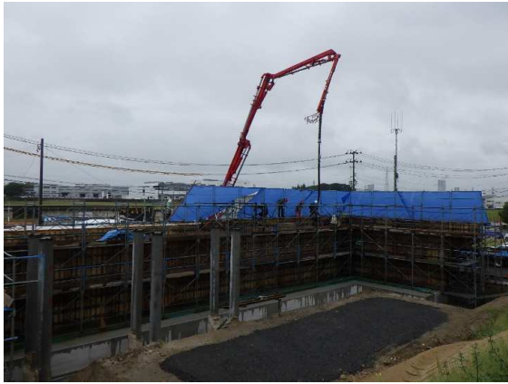
L型擁壁施工状況
