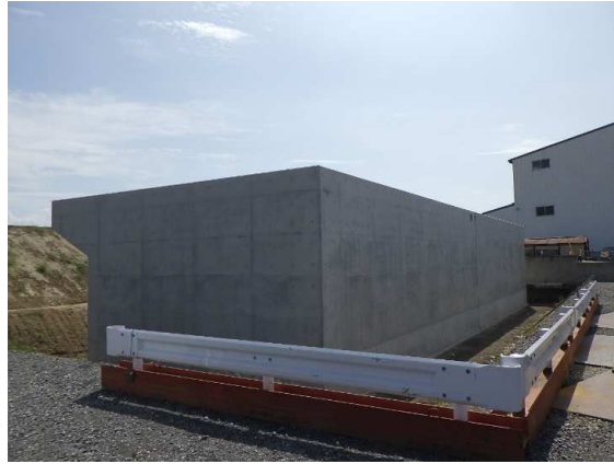
L型擁壁完了
