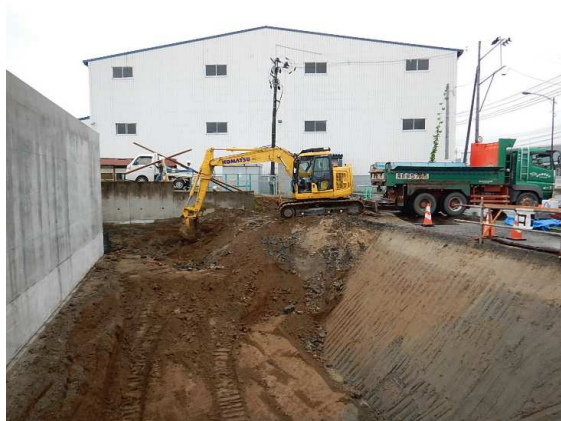
地下オイルタンク施工状況
