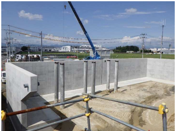
L型擁壁完了
