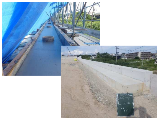
独立L型基礎設置(コンクリート養生～脱型完了)状況
