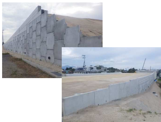
補強土壁工及びL型擁壁設置完了状況
