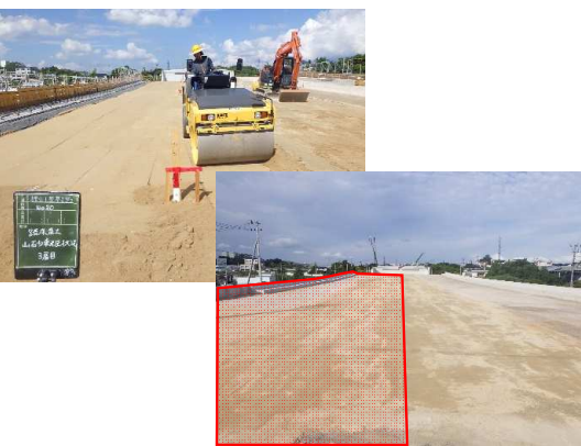
路床盛土(敷き均し転圧～完了)状況
