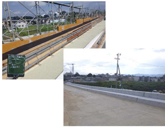
独立L型基礎(コンクリート養生～脱型完了)状況
