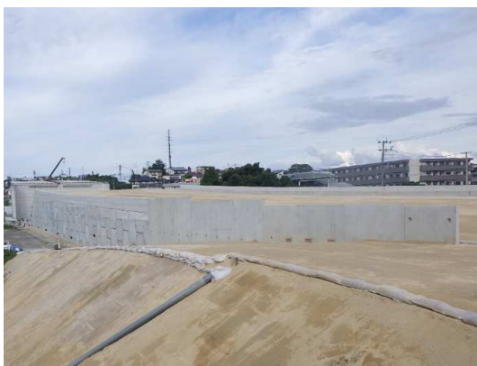
補強土壁工及びL型擁壁設置完了状況
