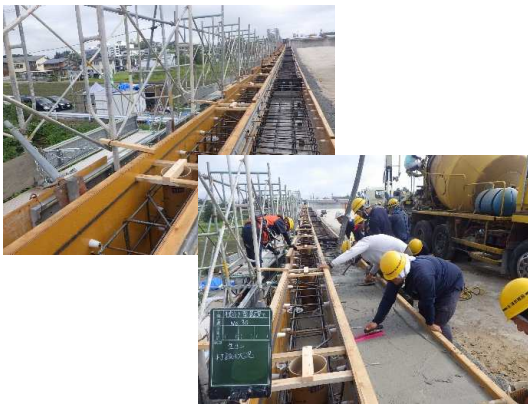
独立L型基礎(型枠～コンクリート打設)設置状況
