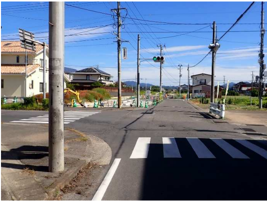
排水工施工状況
