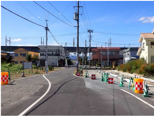
排水工、歩車道境界ブロック設置状況
