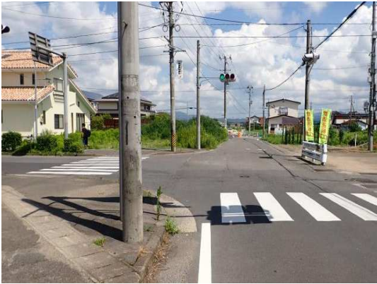
施工前(7月) 東側を望む
