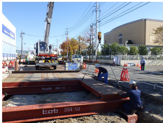
覆工板設置状況
