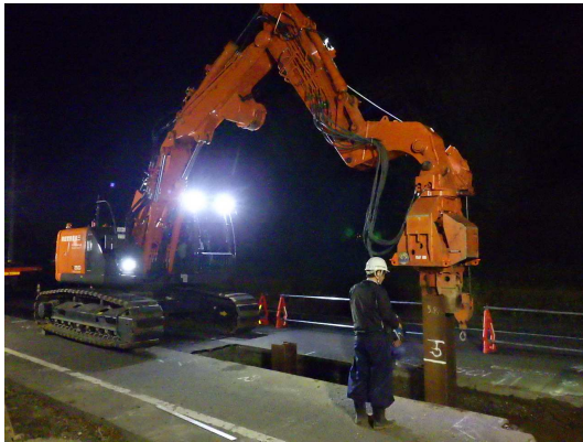
親杭設置状況
