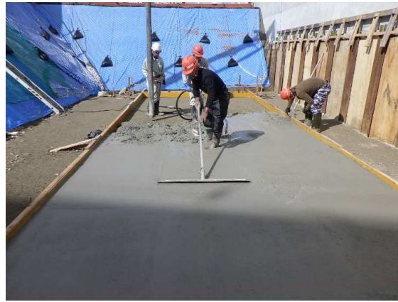
地下オイルタンク均しコンクリート施工状況
