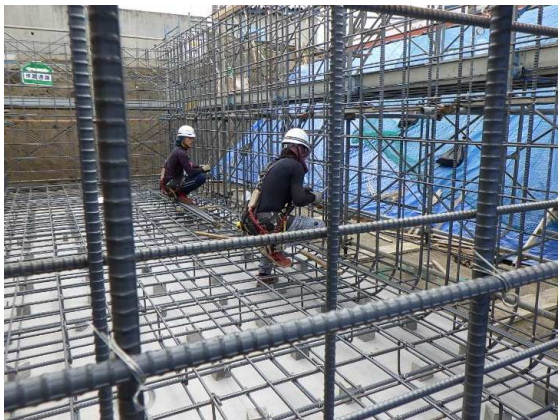
地下オイルタンク鉄筋組立状況
