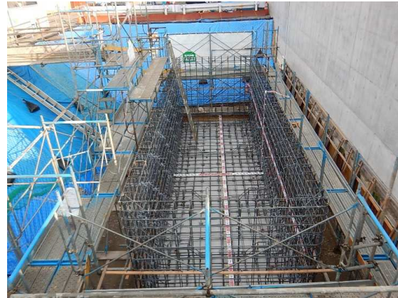
地下オイルタンク鉄筋組立状況
