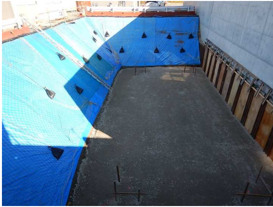
地下オイルタンク基礎砕石完了
