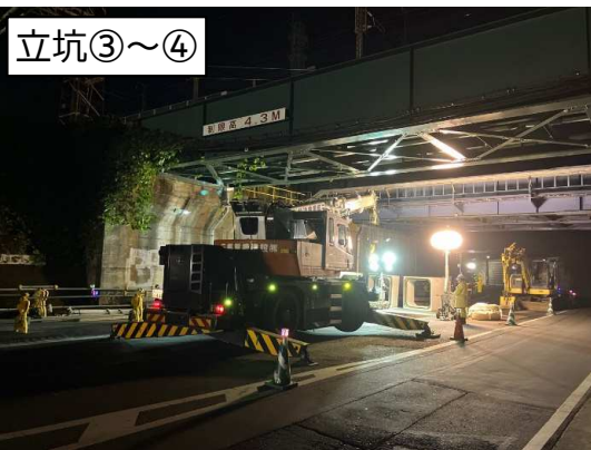
立坑③～④ボックスカルバート布設状況
