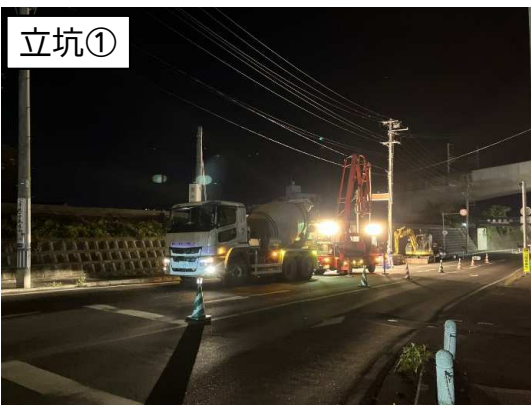
立坑①特殊マンホールコンクリート打設状況
