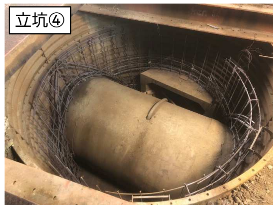
立坑④特殊マンホール鉄筋組立状況
