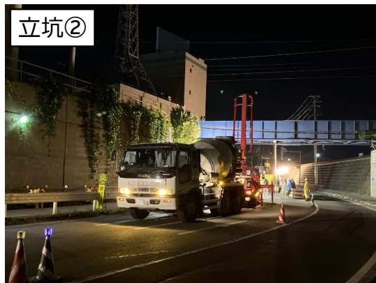
立坑②特殊マンホールコンクリート打設状況
