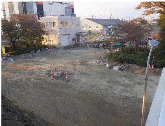
既設放流渠撤去部埋戻し完了
