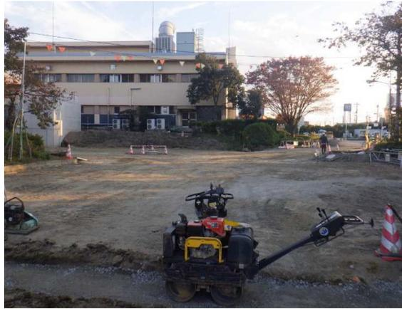
既設放流渠撤去部埋戻し完了
