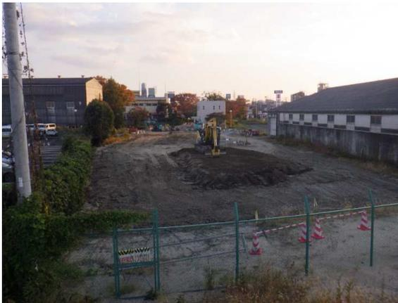
既設放流渠撤去部埋戻し状況
