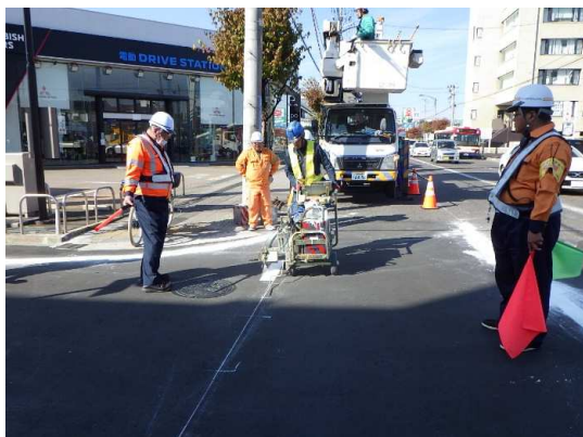
分水人孔②区画線復旧状況
