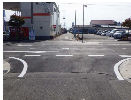
分水人孔③施工完了
