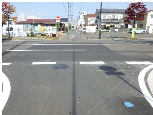
分水人孔②施工完了
