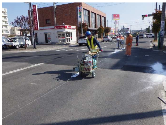
分水人孔③区画線復旧状況
