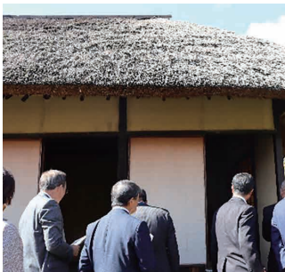
壁や建具の修繕が行われた 開成館の旧小山家
