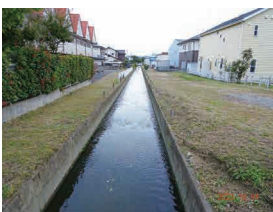
愛宕川河川改修工事箇所
