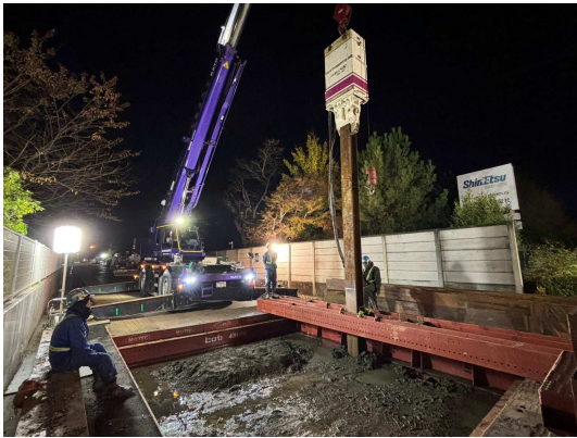
親杭設置状況
