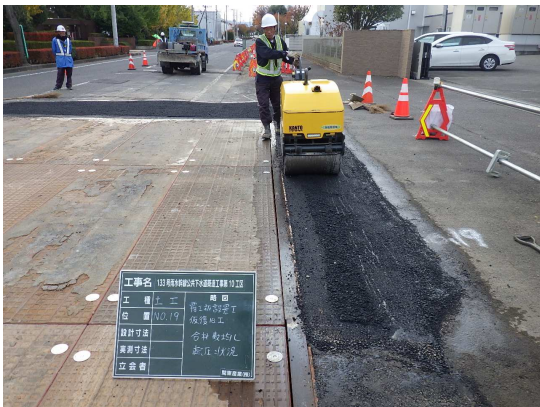
仮復旧転圧状況
