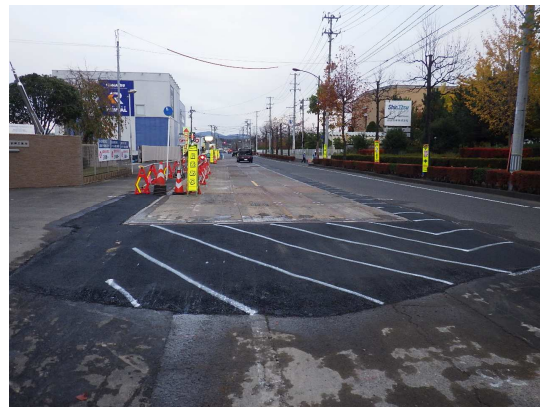
覆工板設置完了
