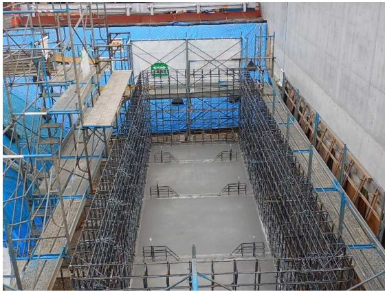
地下オイルタンク鉄筋組立完了
