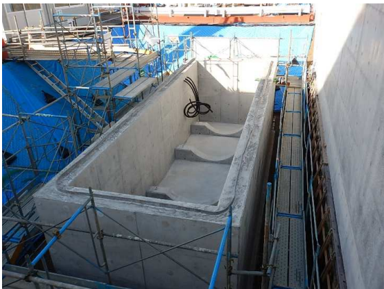
地下オイルタンクコンクリート打設完了
