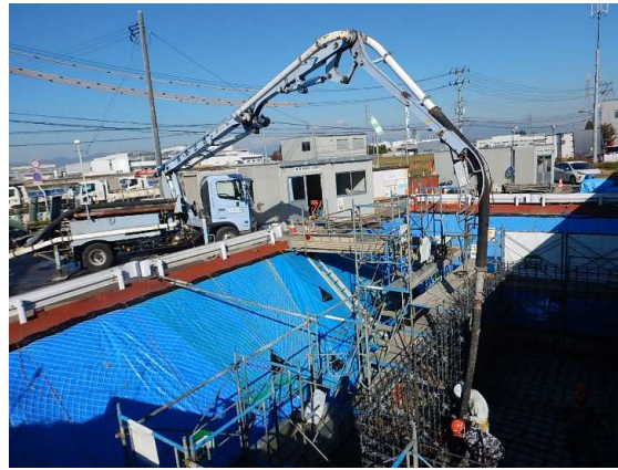
地下オイルタンクコンクリート打設状況
