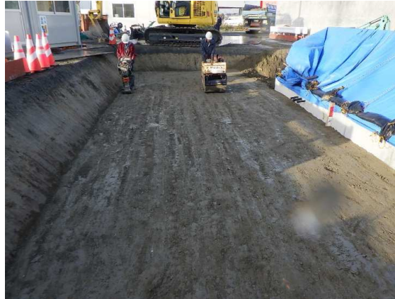
地下オイルタンク埋戻し状況
