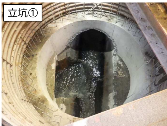
立坑①特殊マンホール築造状況
