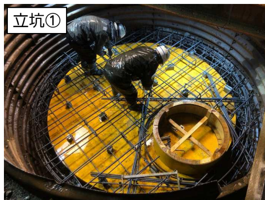
立坑①鉄筋組立状況
