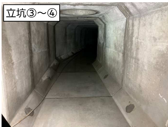
立坑③～④ボックスカバート布設完了
