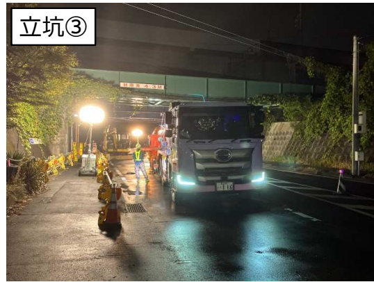
立坑③コンクリート打設状況
