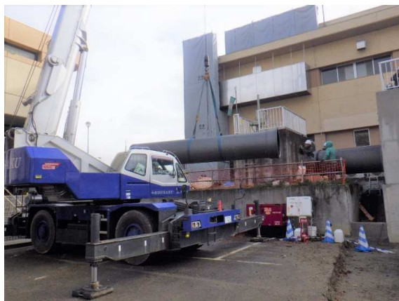
バイパス管布設状況
