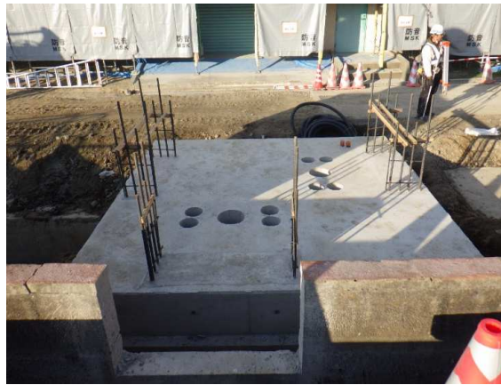
バタフライ弁基礎築造完了
