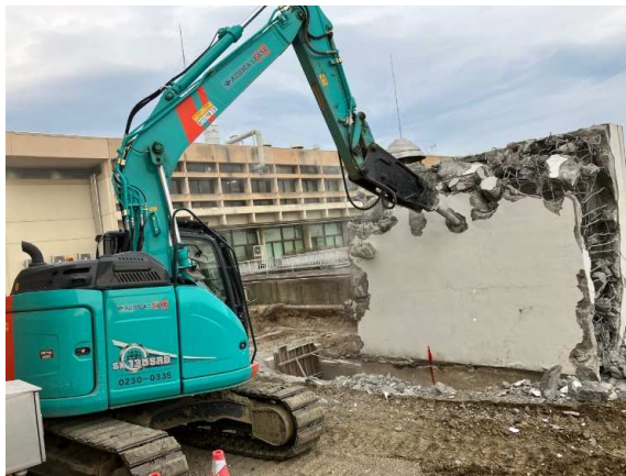
集水井撤去状況
