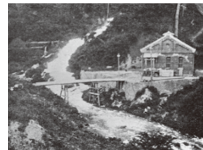
沼上発電所…明治32年に猪苗代湖から低地へ流れる安積疏水の落差を利用した水力発電所。高圧電力の長距離送電により、本市の紡績や繊維産業の発展に大きく貢献した。
