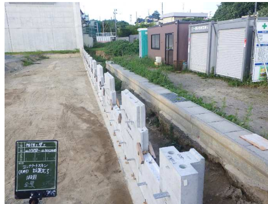
コンクリート壁面材(1段目)設置状況(東側)
