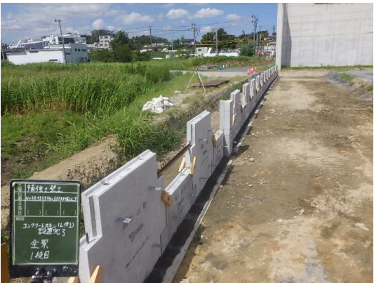
コンクリート壁面材(1段目)設置状況(西側)
