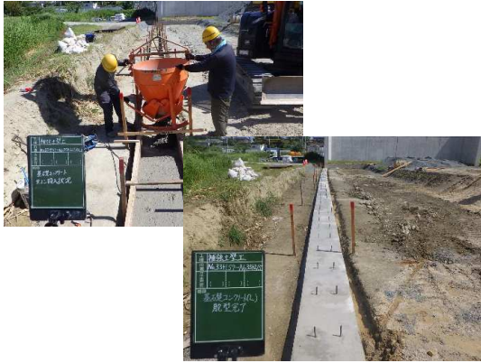
補強土壁工基礎(コンクリート打設)状況(西側)
