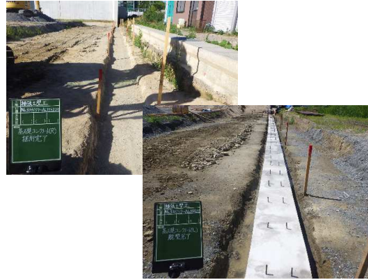
補強土壁工基礎(砕石~コンクリート)状況(東側)
