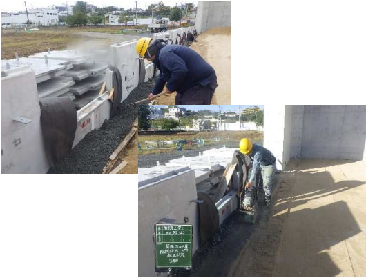
コンクリート壁面材(背面フィルター層)設置状況(西側)
