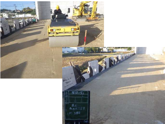
路体盛土(転圧)状況(西側)
