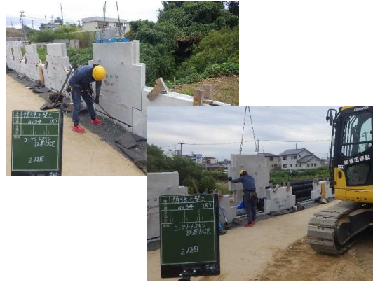
コンクリート壁面材(2段階)設置状況(東側)
