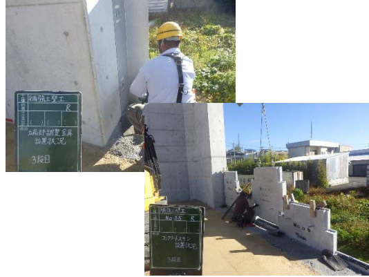
コンクリート壁面材(3段目)設置状況(東側)
