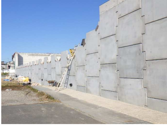
コンクリート壁面材(3段目)設置状況(西側)
