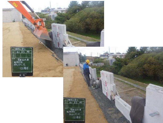
コンクリート壁面材(背面フィルター層)設置状況(東側)
