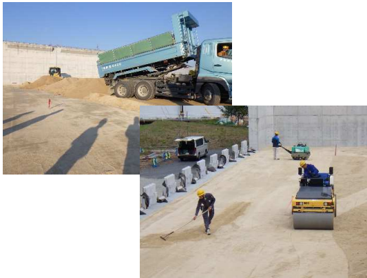
路体盛土(転圧)状況
