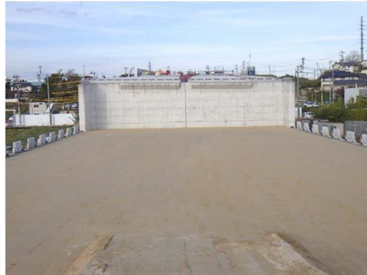
本工事完了(全景)
