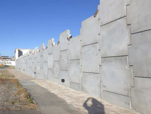
コンクリート壁面材設置完了状況(西側)
