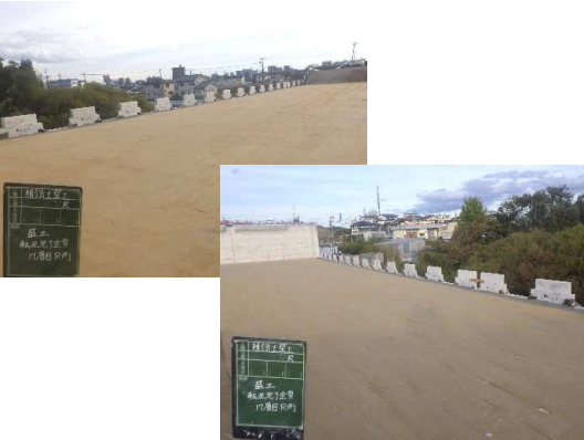
路体盛土完了状況
