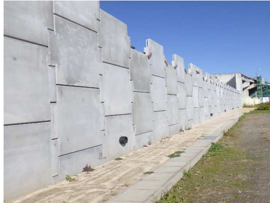
コンクリート壁面材設置完了状況(東側)
