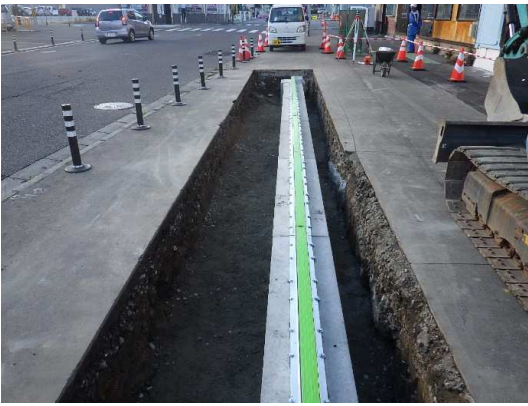
円形側溝設置状況
