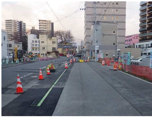
円形側溝設置完了状況
