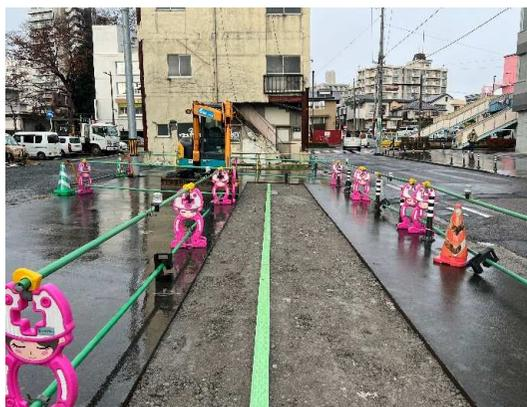
円形側溝設置完了状況
