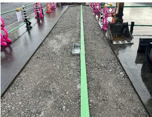
円形側溝設置完了状況
