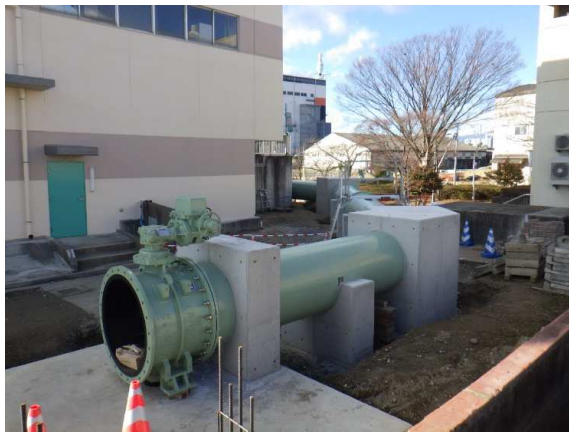
バイパス管布設状況
