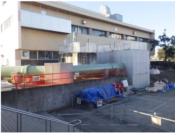
バイパス管布設状況
