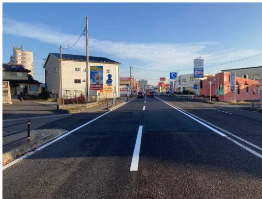
県道部舗装本復旧完了
