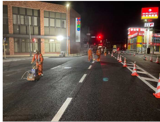
県道部区画線復旧状況
