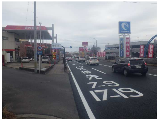
県道部舗装本復旧完了
