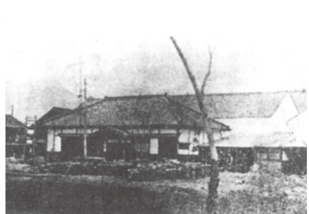
郡山絹糸紡績会社(1898年) 当時の日本では、まだ数が少ない電力を利用した先進的な絹糸紡績会社。沼上発電所の電力を利用し、電力供給事業も併せて行っていた。
