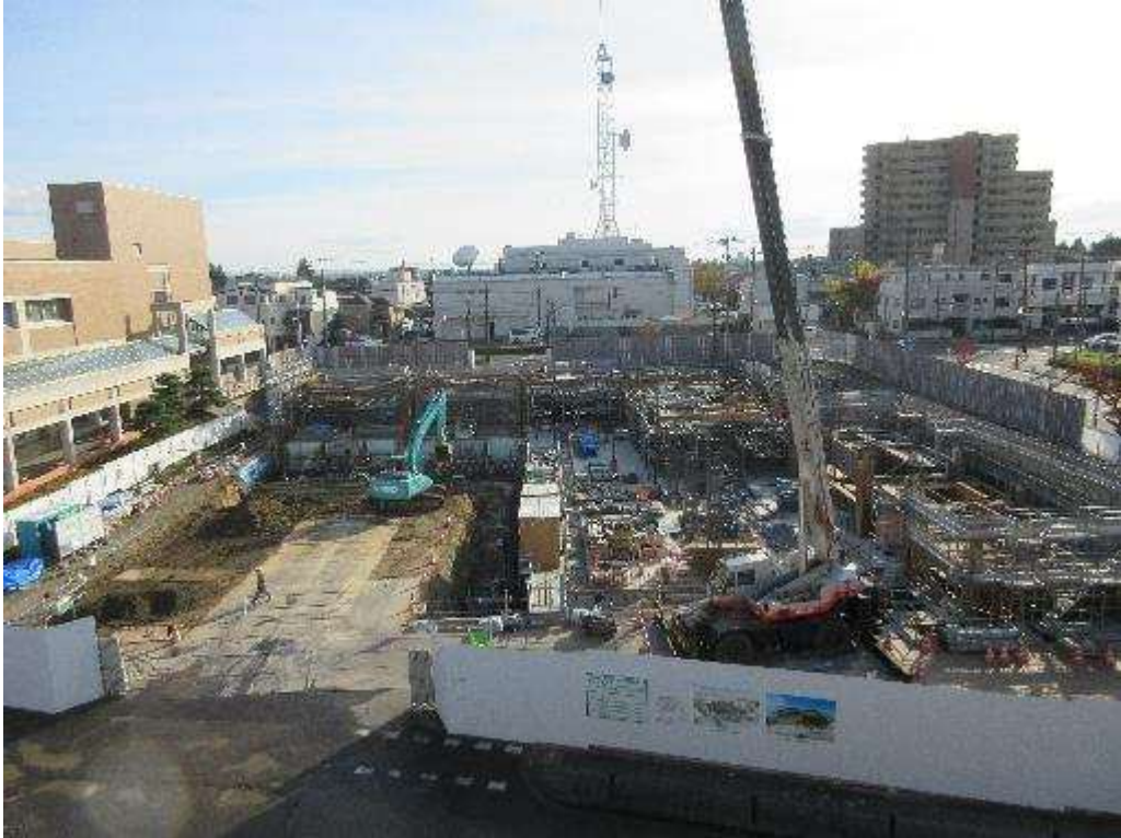
令和5年11月16日午後 現地調査（工事現場）
