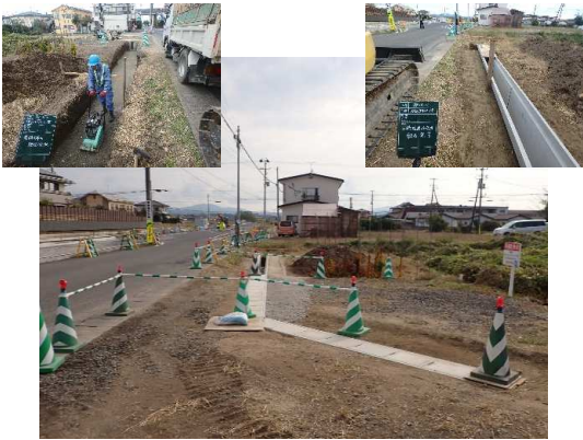
排水工施工状況
