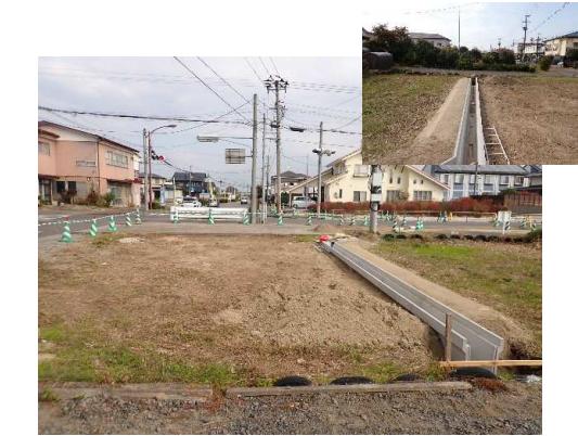
排水工施工状況
