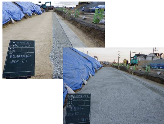
補強土壁工(基盤排水工)施工状況
