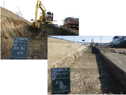
補強土壁工(掘削・床掘)施工状況
