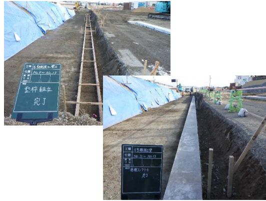
補強土壁工(基礎コンクリート工)施工状況
