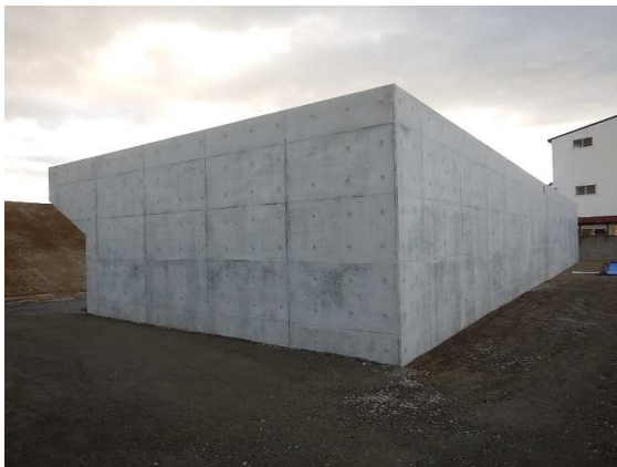
L型擁壁設置完了
