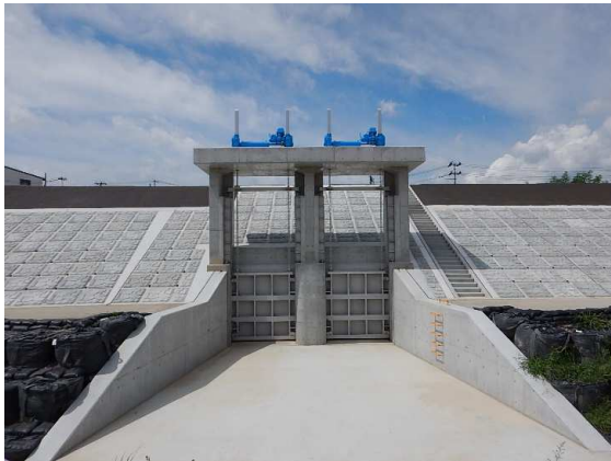
樋門設置完了
