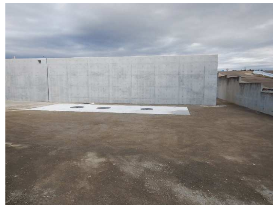
地下オイルタンク設置完了
