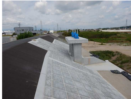
樋門設置完了
