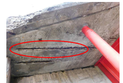
(床版コンクリート補修)
