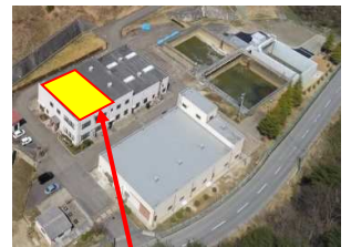
【太陽光パネル設置場所】
