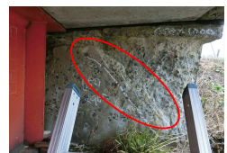
(橋台コンクリート補修)
