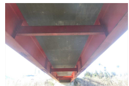
(橋桁の塗装補修)
