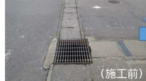
【側溝整備(冠水対策)】
