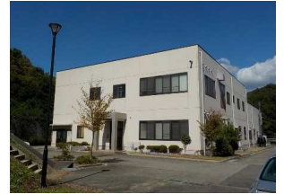
【第二污水处理施設】
