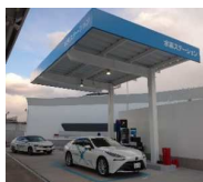
【郡山水素ステーション】
