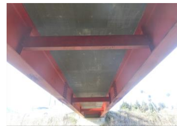
(橋桁の塗装補修)
