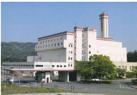
【河内クリーンセンター】
