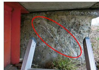
(橋台コンクリート補修)
