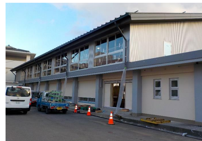
【R5 日和田小屋内運動場 長寿命化改修】
