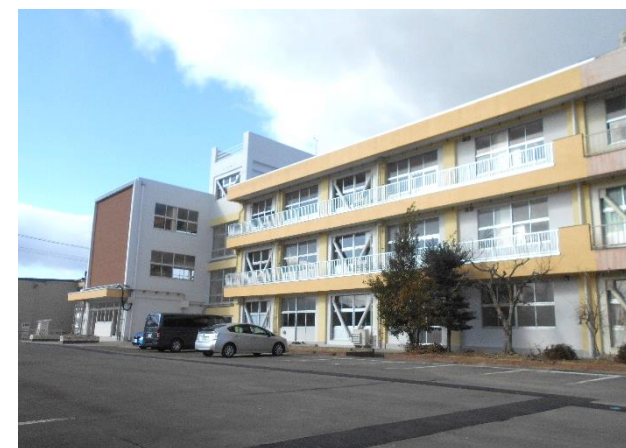
【R5 芳賀小校舎(Ⅰ期) 長寿命化改修】
