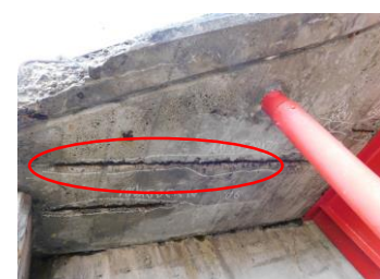
(床版コンクリート補修)
