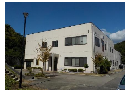
【第二污水处理施設】
