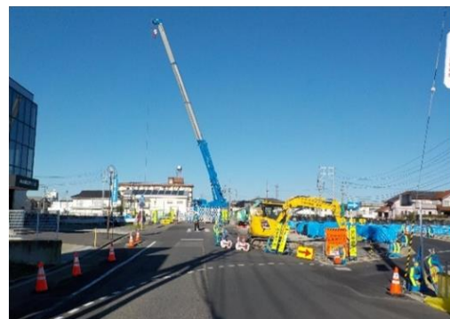
《県施工による咲田橋架替工事整備状況》
