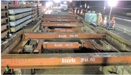
切梁・腹起し設置状況
